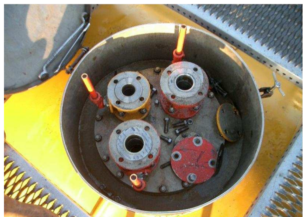
Válvulas manuales de accionamiento con palanca ( válvulas de bola )
