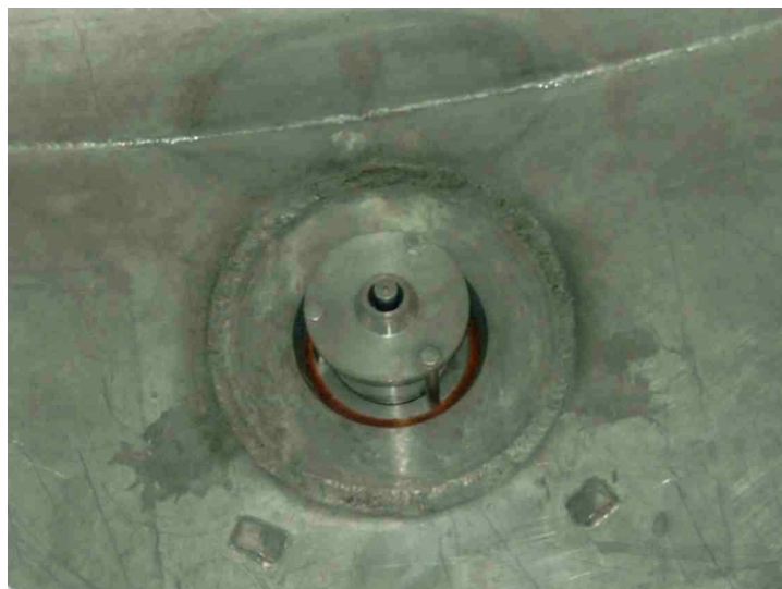
Válvula de fondo, interior cisterna
