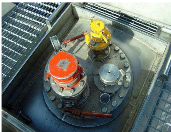
Válvulas manuales de accionamiento con palanca ( válvulas de bola )
