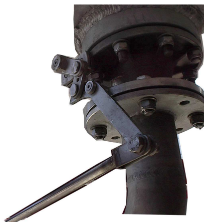
Accionamiento válvula manual de palanca
