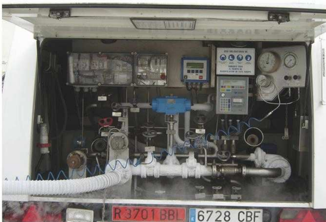
Armario válvulas, controles y accesorios
