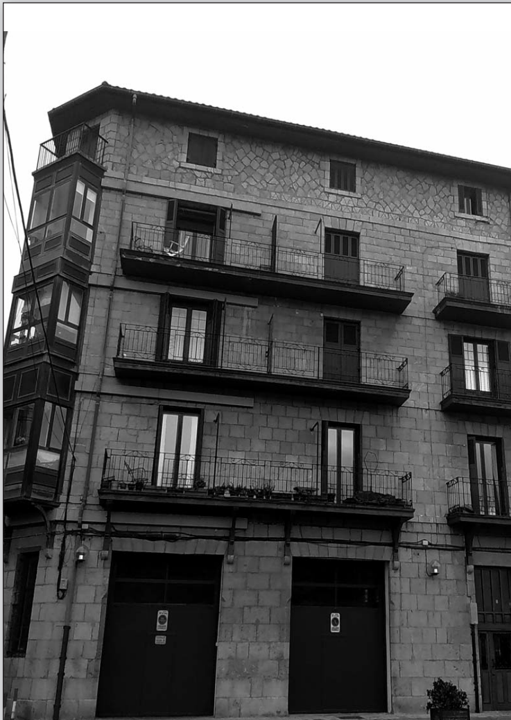
Edificio de la casa frontón donde estuvo la Pensión Azurmendi.
