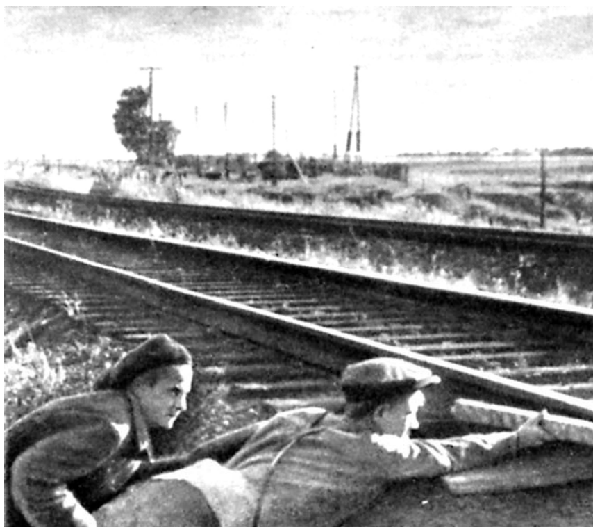
Colocando una mina
