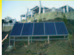
Instal·lació solar fotovoltaica
