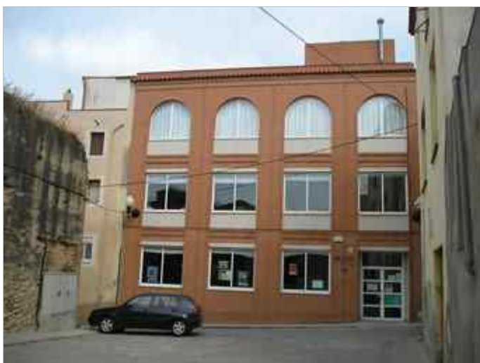
La seu de l'Arxiu Històric, a l'edifici de l'antic Hospital de Constantí.
